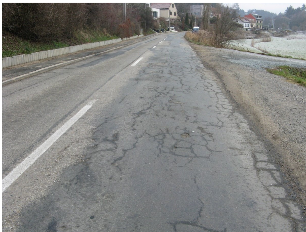
Foto 158 – km 2,600+; celoplošné trhliny v pravém pruhu vozovky
