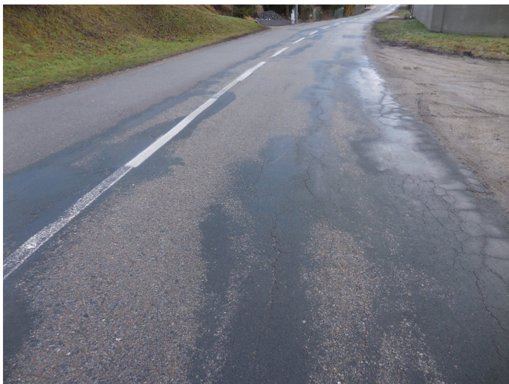
Foto 038 – km 1,400+; síťové trhliny při okraji, plošná deformace, hrboly, vysprávkvy
