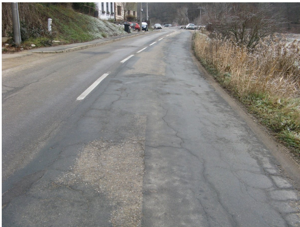
Foto 176 – km 2,760+; trhliny, hrboly, plošná deformace – havarijní stav
