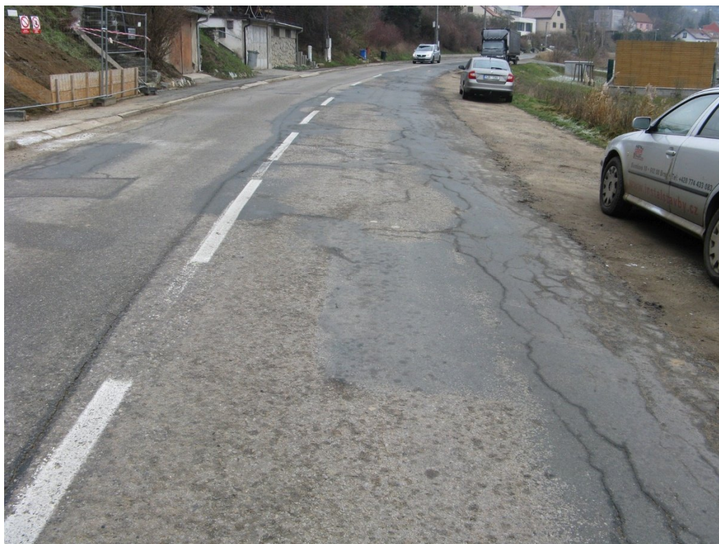
Foto 150 – km 2,520+; trhliny, vysprávkky, deformace vozovky
