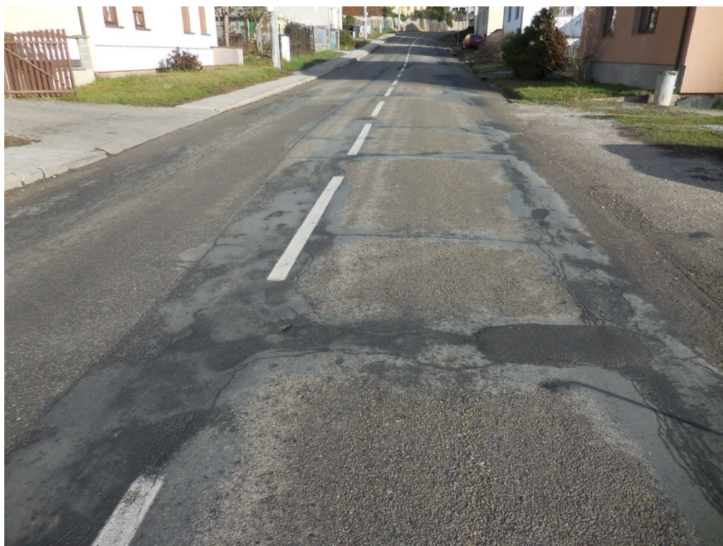
Foto 096 – km 1,980+; podélné a příčné trhliny, vlevo při okraji síťové trhliny
