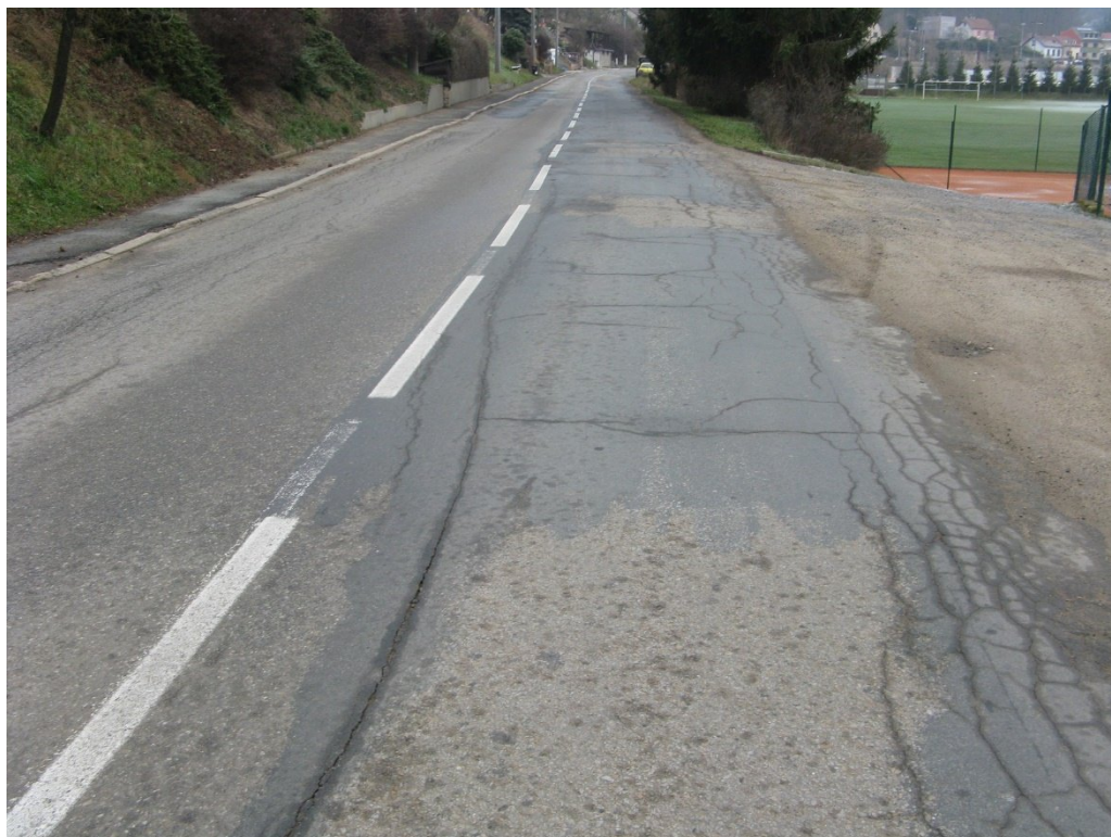
Foto 138 – km 2,400+; síťové trhliny u obou okrajů vozovky
