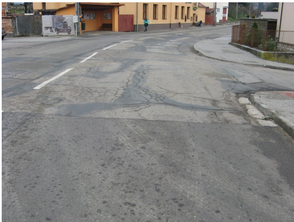
Foto 124 – km 2,260+; rozhraní opraveného povrchu cca uprostřed Řícmanic
