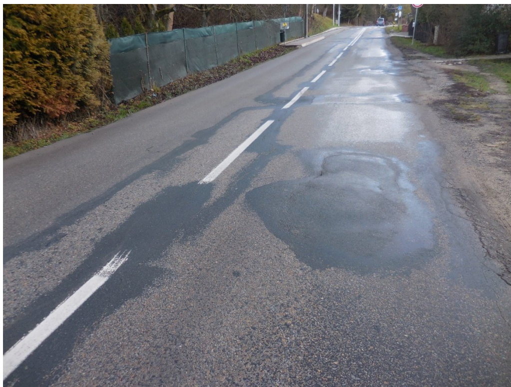
Foto 046 – km 1,480+; olámaný okraj, vlevo vozovka po výpravě kanalizační rýhy
