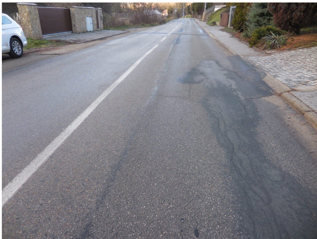
Foto 074 – km 1,720; konstrukční poruchy na vozovce po stavebním zásahu do kanalizace
