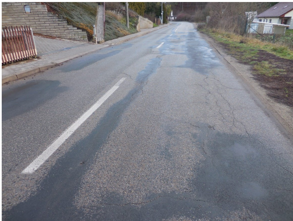
Foto 062 – km 1,640+; podélné rozvětvené až síťové trhliny, hrboly z vysrávek
