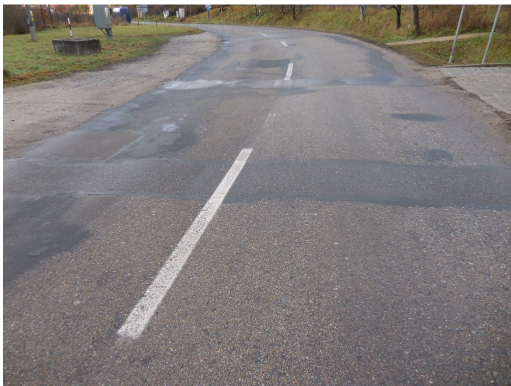
Foto 009 – km 1,100-; vysprávkky, deformace (příčný překop), nepravidelné hrboly
